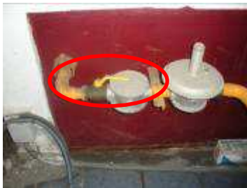
Llave de corte en sala de calderas
