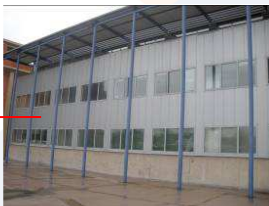
Edificio Anexo. Fachada Norte
