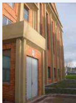
Puerta de evacuación salón de actos vista desde el exterior
