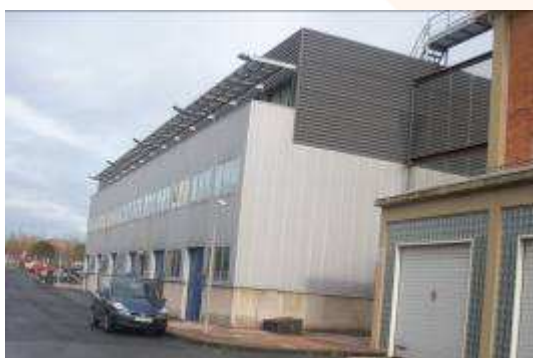
Edificio Anexo. Fachada Sur
