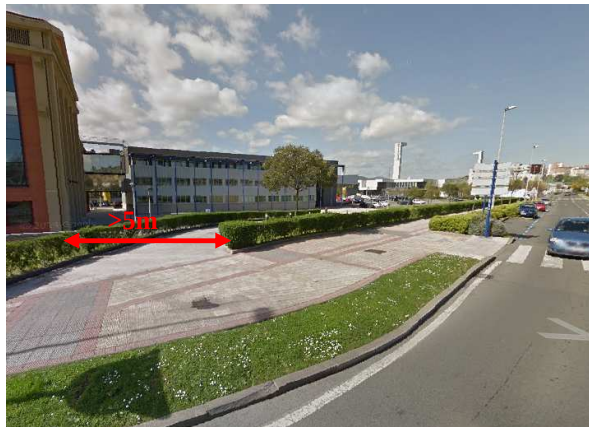
Acceso desde la Avenida Altos Hornos de Bizkaia. Anchura de paso >5 metros.
