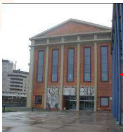
Acceso principal. Edificio Ilgner. Fachada Noroeste
