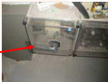
Existen dos interruptores de corte general del edificio Anexo
