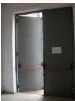
Puerta de evacuación salón de actos vista desde el interior
